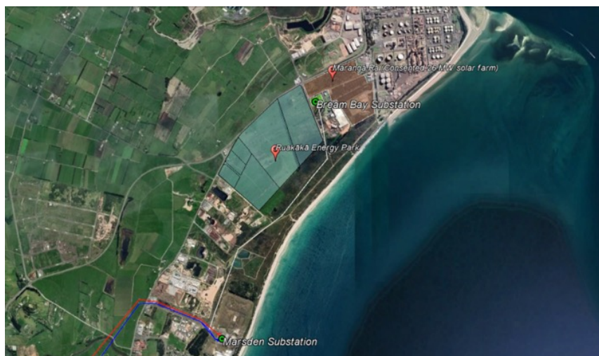
Ruakākā Energy Park site
